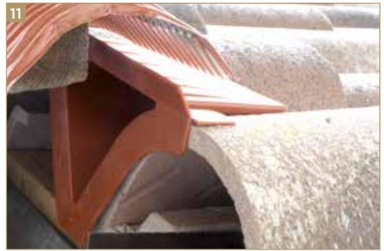
Esempio di posa della bocchetta di areazione. La bocchetta di areazione non può scivolare verso il basso, è consigliabile comunque impedire anche eventuali possibili risalite verso l'alto bloccandola con una goccia di silicone alla tegola sottostante.
