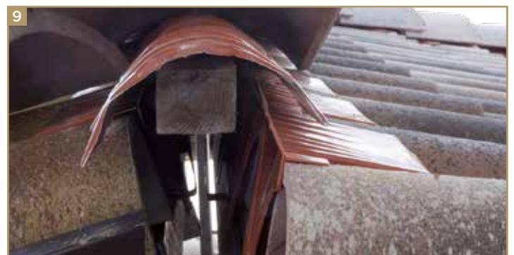
Il Sottocolmo Imperiale in alluminio serve per portare all'esterno della falda eventuali infiltrazioni d'acqua dalla linea di colmo. Nel caso (sconsigliato) di uso di malta per bloccare i colmi continua a garantire l'aerazione del tetto mantenendo libere le bocchette di areazione.
