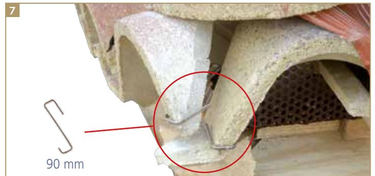
Nel caso del tetto a padiglioni non è possibile usare la scossalina che permette una chiusura laterale del tetto con il coppo imperiale® terminale sx. Si arriva sul vertice basso del displuvio con un pezzo di tegola tagliato a misura, che dovrà essere sostenuto con un pezzo di legno o con un po' di malta o schiuma ed essere agganciato alla rete parapasseri mediante un gancio ad "S" lunghezza 90 mm. La tenuta della giunzione è assicurata dal sottocolmo aerato e dal finale.
