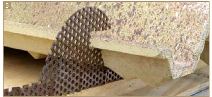
Esempio di appoggio corretto della prima tegola in gronda. Sporgenza della linea di gronda: 95 mm.
