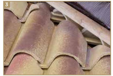
In presenza di displuvi in cui si eseguono tagli inclinati bisogna porre attenzione a terminare con il canale di deflusso chiuso in maniera appropriata avendo cura di inserire tutti i pezzi necessari (vedi fig.1-2-3).
