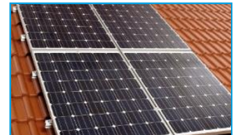
5 Fotovoltaico su Tegole di Supporto
